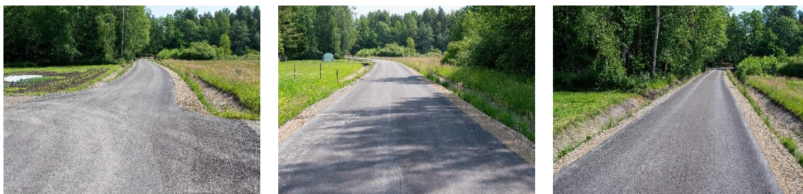
Zdjęcia: Zrealizowana inwestycja drogowa w miejscowości Kamionka.
