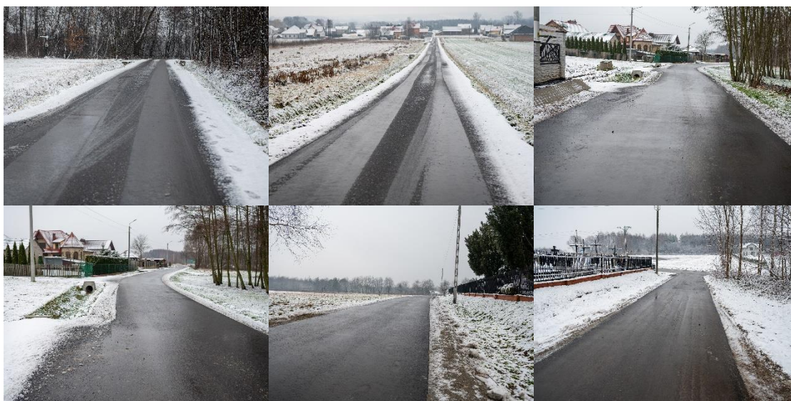
Zdjęcia: Zrealizowane inwestycje drogowe w miejscowościach: Borek Mały, Ostrów, i Skrzyszów.
